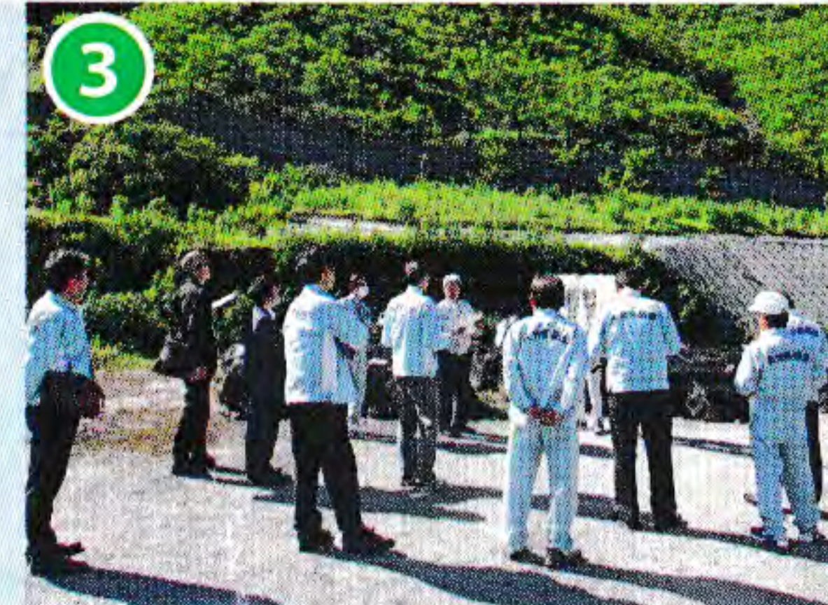
平成30年、降雨や地震等の前兆現象がない中、突然崩壊し甚大な被害を及ぼした耶馬溪町金吉地区では今も対策工事が続く。
