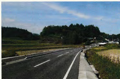
令和5年に開通した久住中心部を通る県道30号庄内久住線は歩道整備を終えた。国道442号との接続箇所は終了しているが途中の整備は残る。
