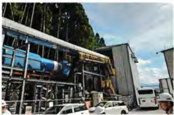
太田委員長(由布市)以下、地域高規格道路の中津・日田道路を視察。最新の技術を用いながら安全第一で、着々と整備が進むトンネル工事。
